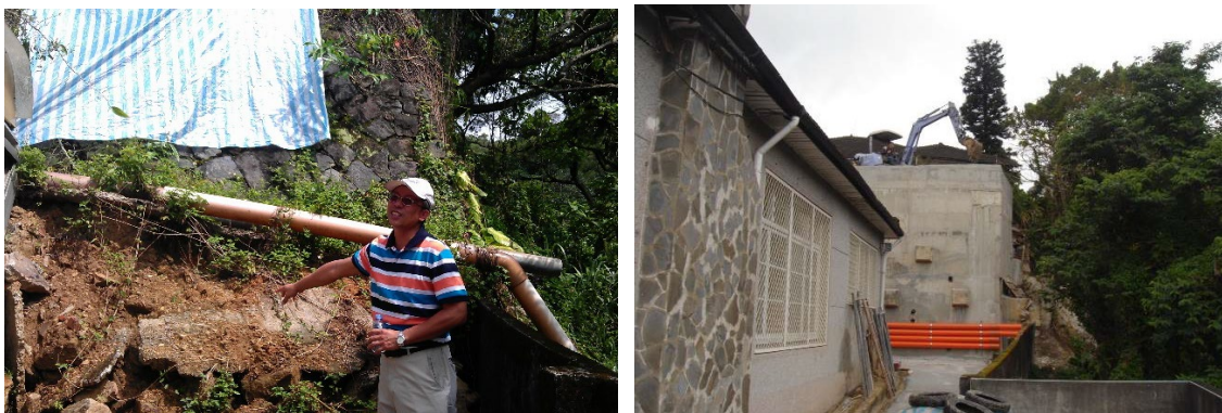
照片5 輔導本市北投區房屋前駁坎修復坡地災害搶修及水土保持處理情形
