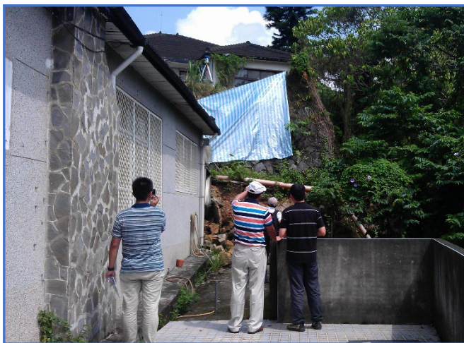
圖7 駁坎毀損以R C擋土設施搶災修復之輔導案例
