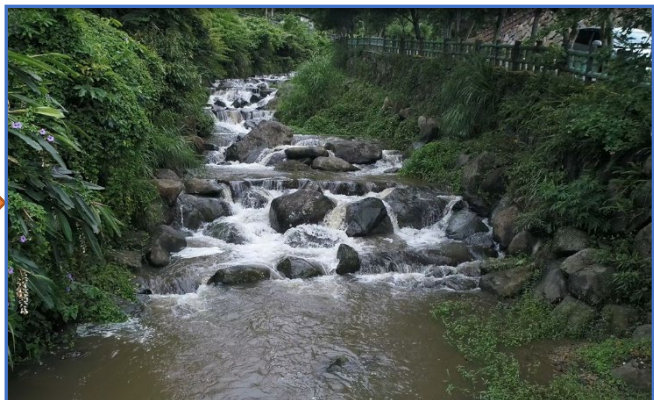
圖 8 溪溝整治工程之輔導案例
