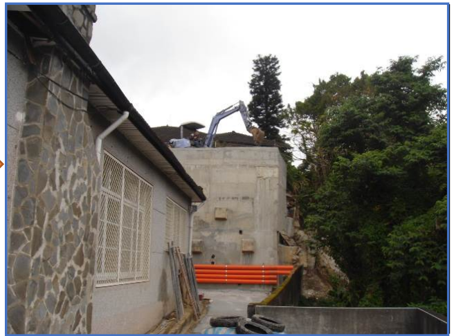
圖7 駁坎毀損以R C擋土設施搶災修復之輔導案例
